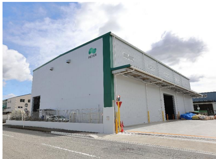
東松山事業所 新工場外観
