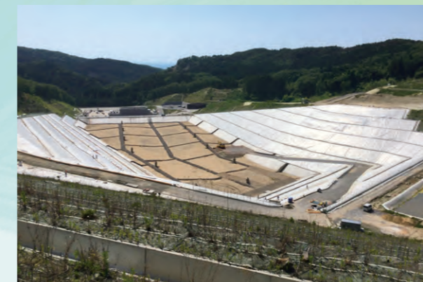
門前クリーンパーク管理型最終処分場の全景
