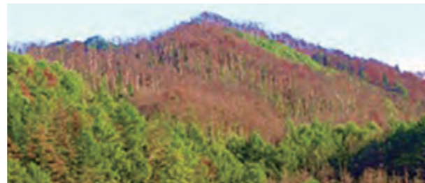
■松くい虫被害により枯死し変色した山林
