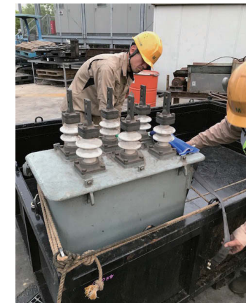
PCB が含まれる油が入ったトランスを運び出し
