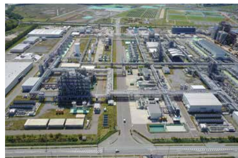
福島県相馬市に取得した事業用地(プラント解体・整備中)
