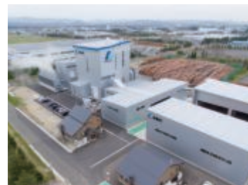
(株)花巻バイオマスエナジー(バイオマス発電所)
