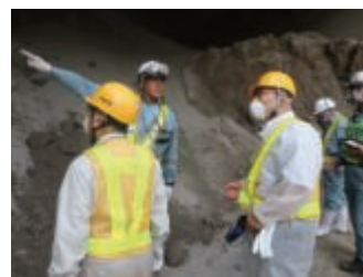
労働安全コンサルタントによる現場巡視の様子
