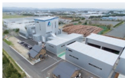
(株)花巻バイオマスエナジー(木質バイオマス発電所)
