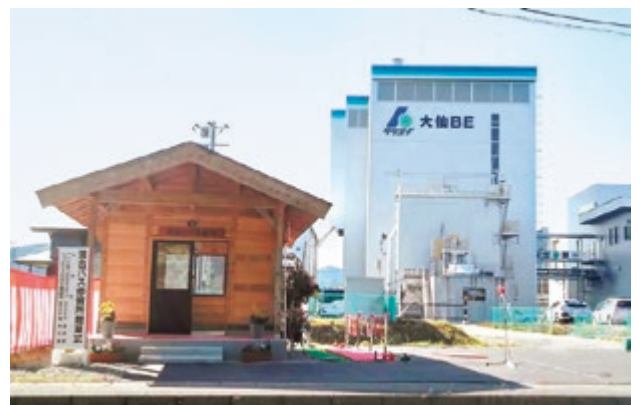
余熱を活用した床暖房を備えた新しいバス停留所((株)大仙バイオマスエナジー)
